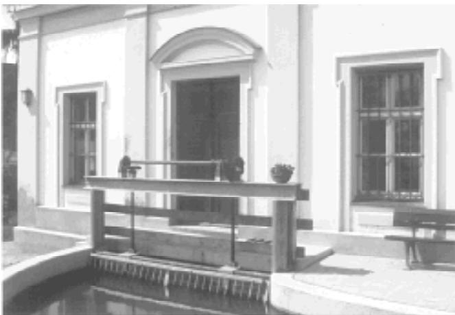
Der 3m tiefer liegende Brunnbach fließt bei geschlossenem Wehr in die Pumpenanlage
